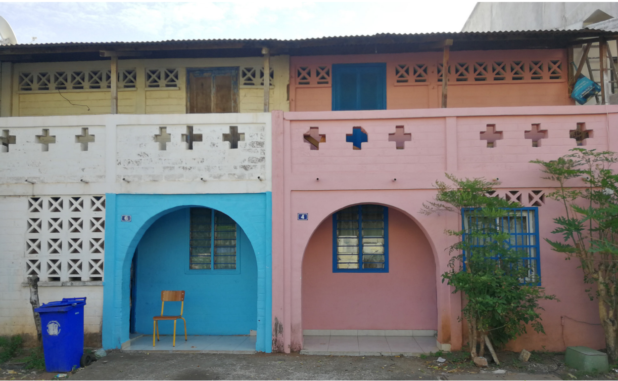
Maisons mitoyennes de case SIM qui existe encore dans le centre-ville de Mamoudzou. Les habitants ont apporté de nombreuses transformations suivant leurs usages. Crédit Photo : Ning Liu, Building For Climate architectes, 2022.
